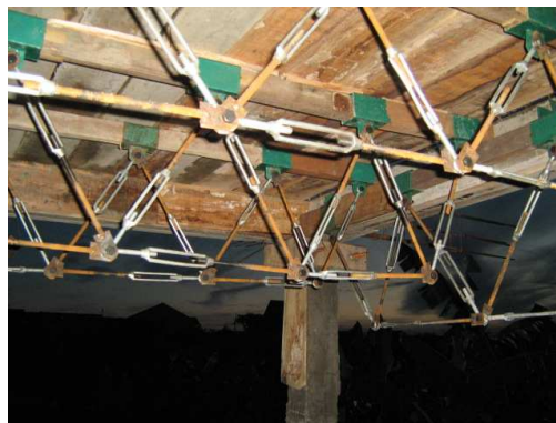
Gambar 4. Uji Eksperimen Aplikasi Pengecoran Lantai Rumah Tinggal
